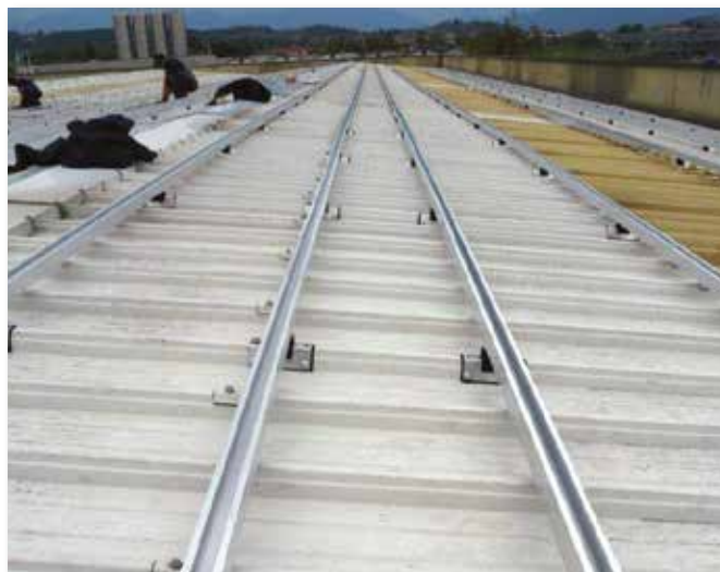
Tetto in lamiera grecata. Applicazione con staffe a disegno FVT95XX.
