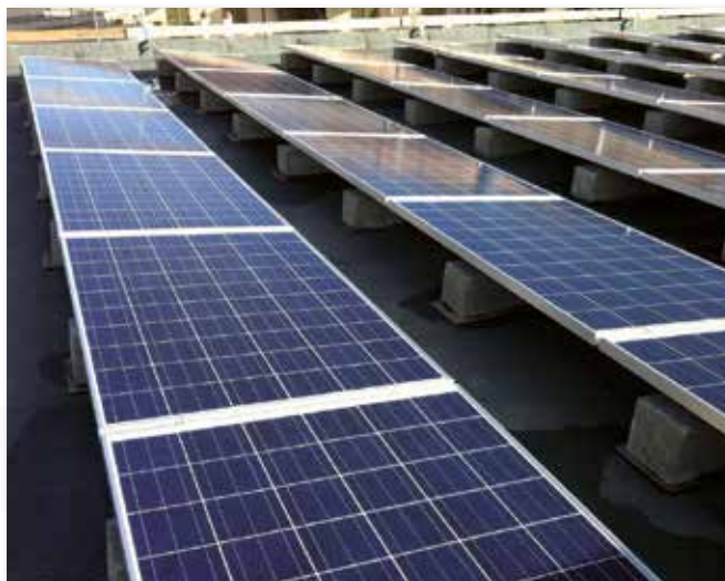
Pannello orizzontale e zavorre Flat.
