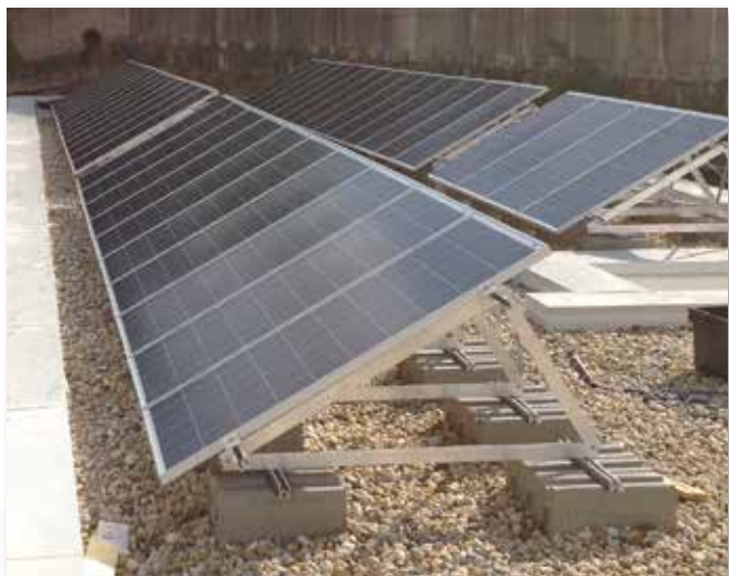
Triangolo singolo verticale a 30° zavorrato.
