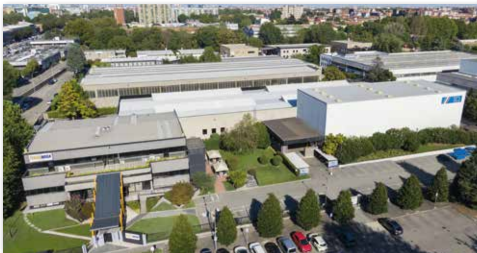
Sede centrale e Centro logistico di Corsico, Milano
