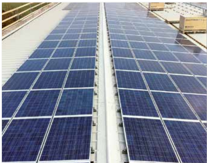
Tetto in lamiera grecata e FVT5000.
