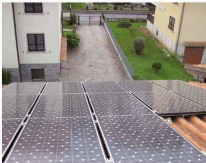
Tetto a falda con tegole. Applicazione con staffa Inox regolabile FVT1256.
