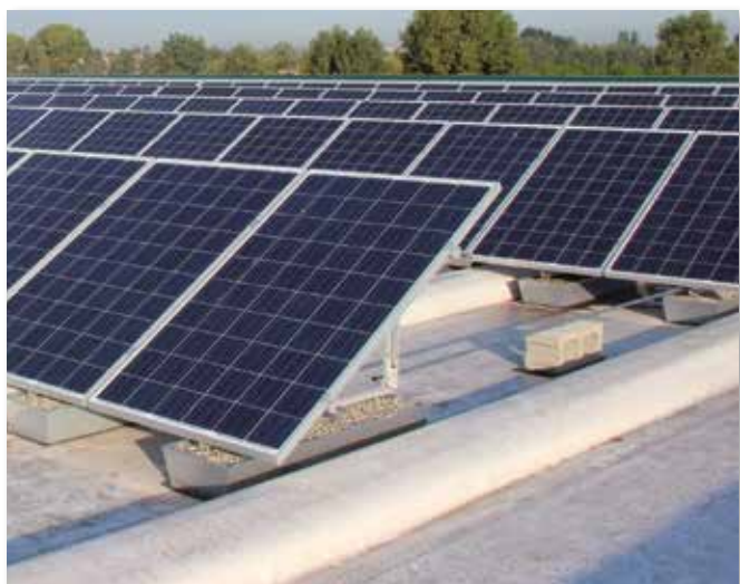
Pannello singolo verticale a 30° con vasche zavorra.
