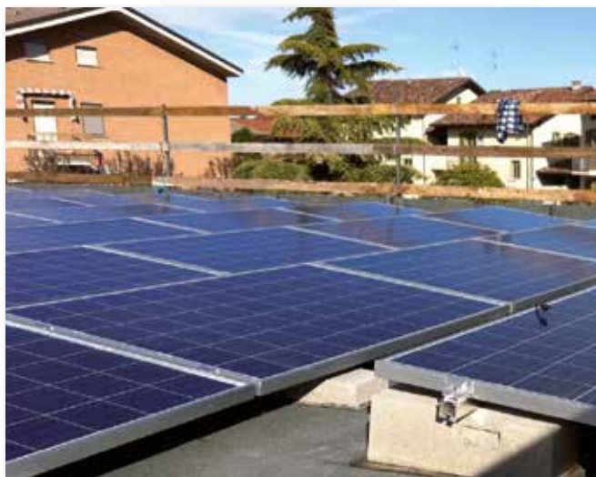
Tetto piano pannello orizzontale e zavorre flat.
