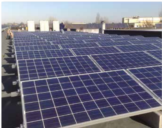
Tetto piano con triangolo singolo verticale zavorrato.
